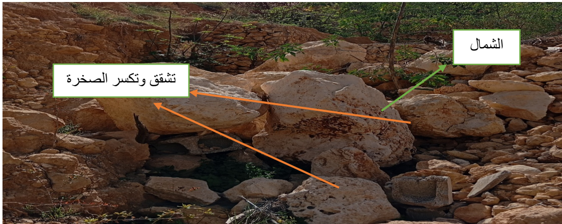
الصورة (7) تشقق وتكسير الصخور في المنطقة الدراسة
